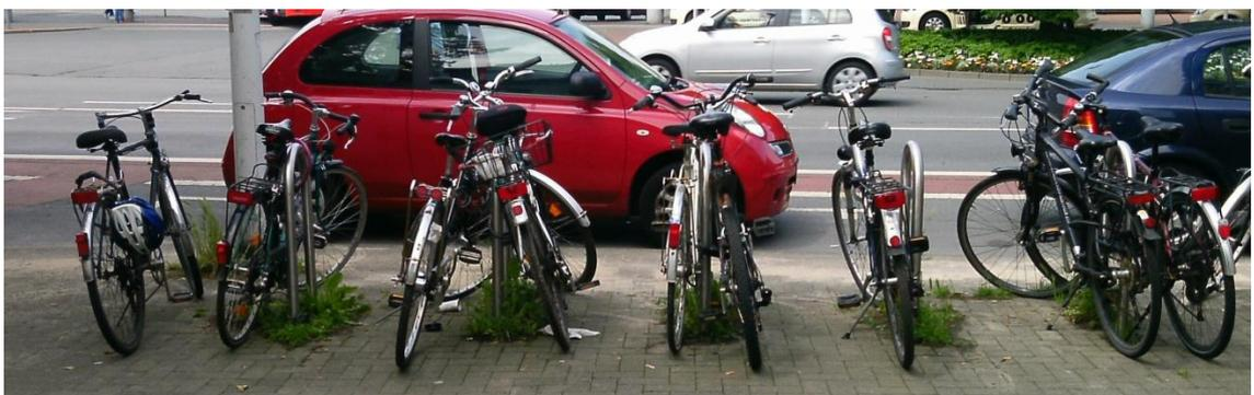
Für eine komfortable Doppelaufstellung werden laut einschlägigem Regelwerk 100 cm, besser 150 cm empfohlen. Mit kleineren Abstrichen beim Komfort (geringerer Bewegungsspielraum) ist eine Doppelaufstellung aber auch schon bei engeren Bügelabständen möglich (hier im Bild die Anlage Nr. 57 mit 90 cm Bügelabstand).
