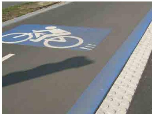
Bild 7-5 Taktile Trennung zum Gehweg (e Radschnellweg Göttingen)
