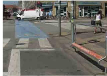
Bild 7-21 Trittbrett an einer Lichtsignalanlage
