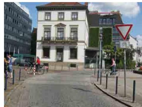
Bild 7-10 Aufgepflasterte bevorrechtigte Querungsstelle eines selbstständig geführten Radweges (Bremen)
