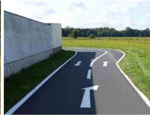
Bild 7-8 Aufweitung in einer unübersichtlichen Kurve (Luckenwalde)
